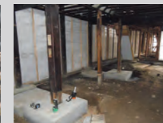
基礎新設の様子
