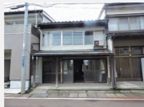
シェアハウス大町 改修前
