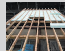
屋根改修の様子
