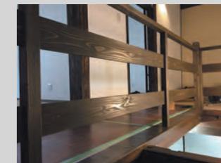
廃材から製作した手摺り
