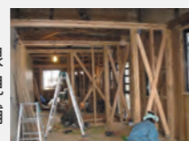
袖壁を新設して耐力壁に
