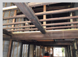
シェアハウス大町工事写真
