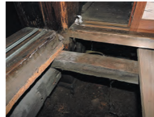
シェアハウス大町の床下
