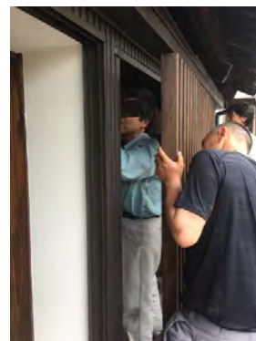
外壁室外機隠しの格子の取り付け
