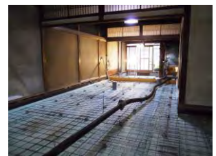
土間床断熱と土間コン
