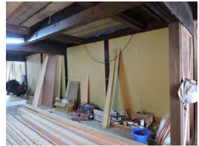
断熱材を施工
