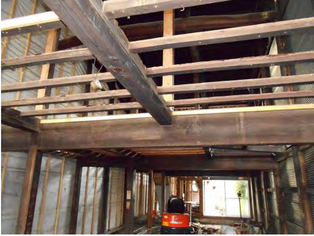
シェアハウス大町工事中の写真
