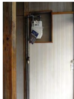
ガスメーター回り
