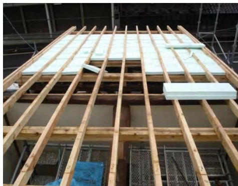
垂木を取替、屋根面に断熱施工
