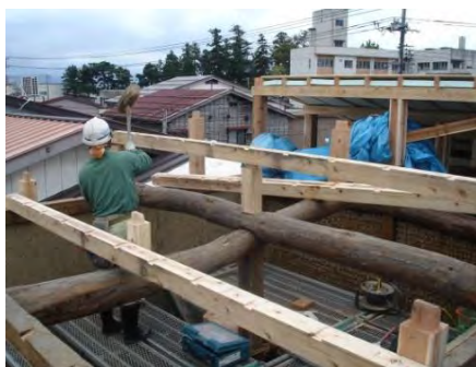
屋根部材撤去後、屋根勾配変更
