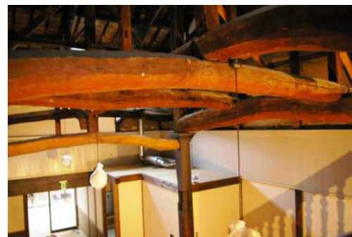
(上段) 途中で切断された吹抜の小屋束に受梁設置 (下段) 洋風の柱頭飾りとペンキ塗壁、天井を復元
