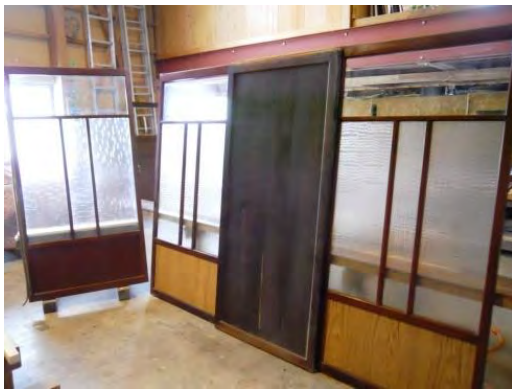
工事中：古い建具を再利用
