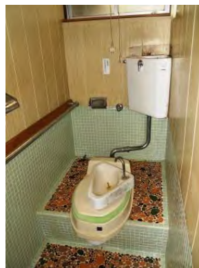
改修前1階便所
