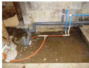
新設トイレの給排水管
