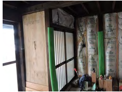
断熱材を施工
