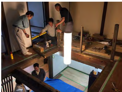
有志の大工さんによる吹抜の手すり製作
