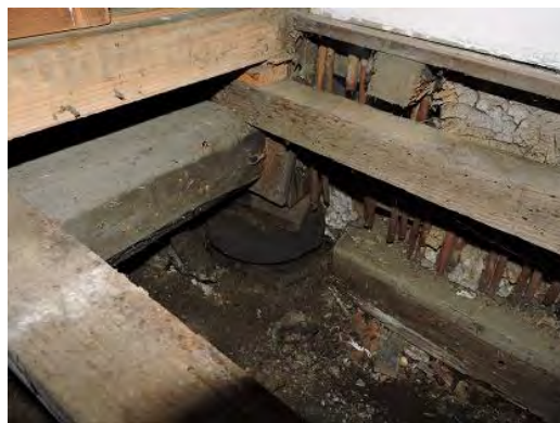
既存の基礎の様子
