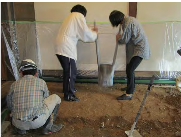
三和土施工体験の様子
