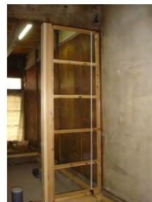
袖壁設置で耐震要素を補強
