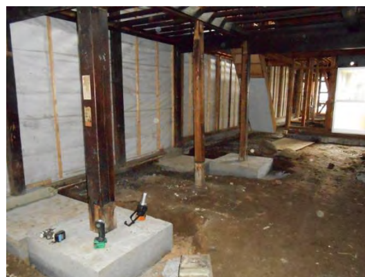
新設された基礎
