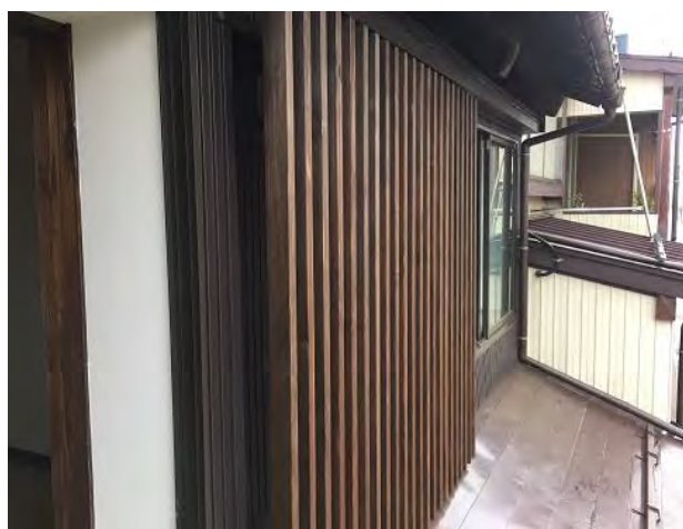
完成した室外機隠しの格子
